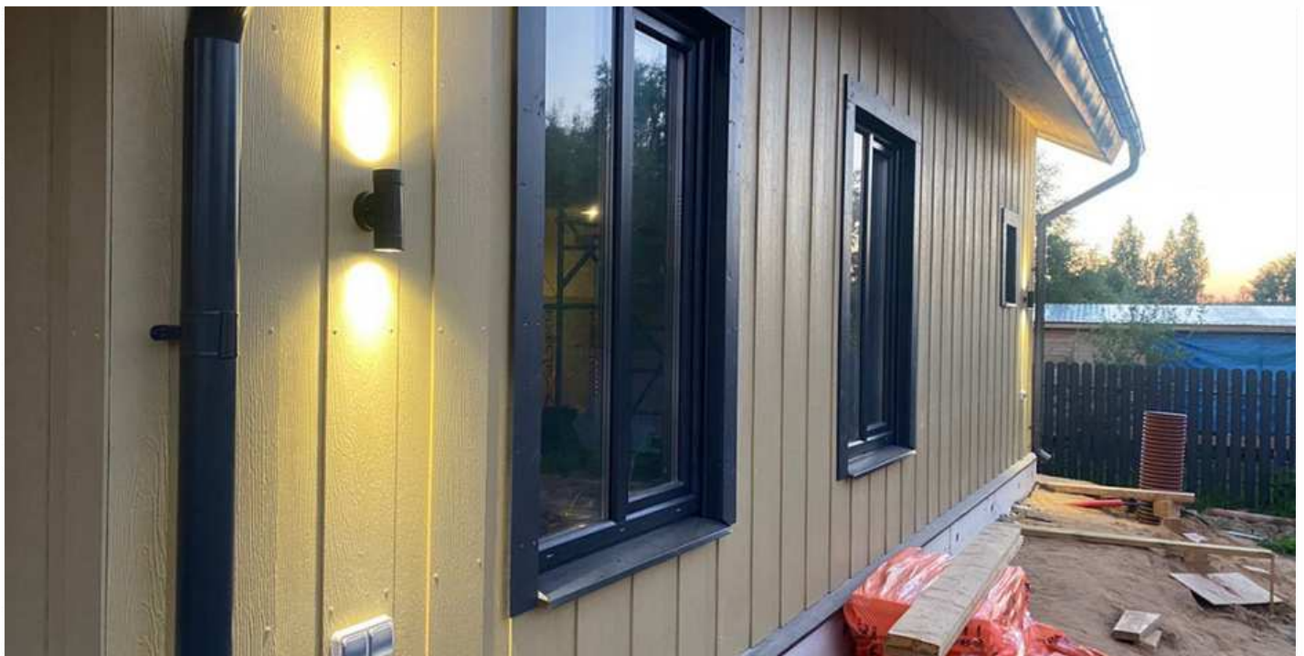
Для аккуратной отделки размещайте саморезы с окрашенными шляпками в цвет материала по одной горизонтальной линии.
