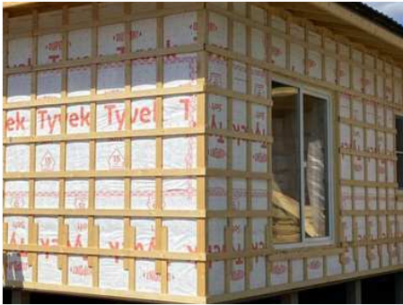
Установите еще один слой горизонтальных брусков.
